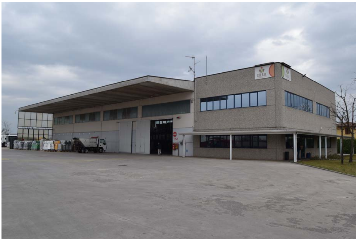
Fig. 2 – Edificio in oggetto – lato ovest.
